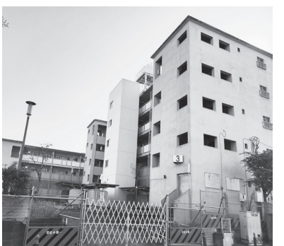
区営東砂住宅（東砂7丁目）
