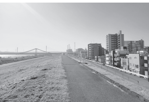
街路灯が未設置の荒川堤防（東砂6丁目）
