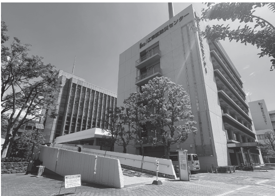
江東区役所の庁舎（左奥）と防災センター（右手前）
