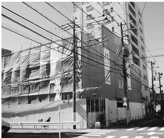
建設中の認可保育園（江東区千田）
